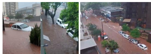
Figura 5. Imagens de alagamentos no centro da cidade de Umuarama-PR, nos anos de 2023 e 2024. Fonte: Esquerda: https://portalumuaramanews.com.br ; Direita: Hoje Mais Maringá, 2024.
