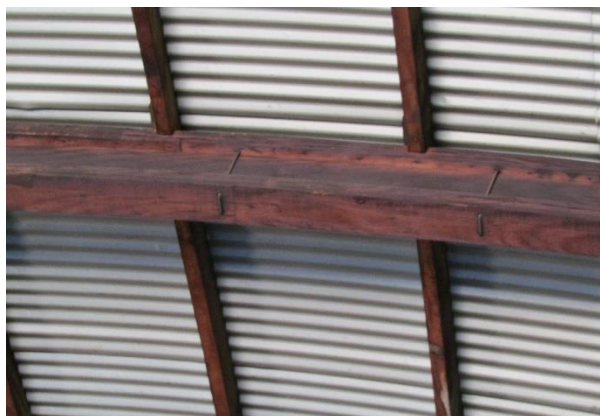
Figura 1. Arco de madeira pregada e grampeada, de um galpão com 20 m de vão, construído em 1976. Fonte: Obtido pelos autores.
