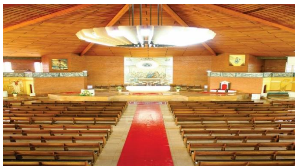
Figura 1. Aspecto do forro e vigas de madeira lamelada e colada (MLC) da Catedral de Umuarama. Fonte: 17
