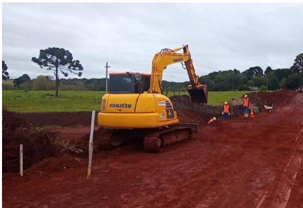
Figura 1. Escavação de Solo – Escavadeira. Fonte: Os Autores (2025).
