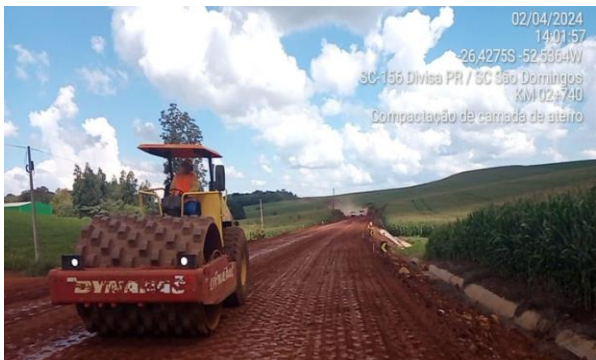
Figura 2. Compactação de Solo – Rolo Compactador Tandem. Fonte: Os Autores (2025).
