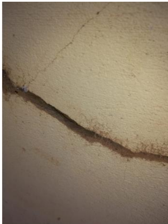
Figura 18. Sujidade no interior da abertura. Fonte: Autores.
