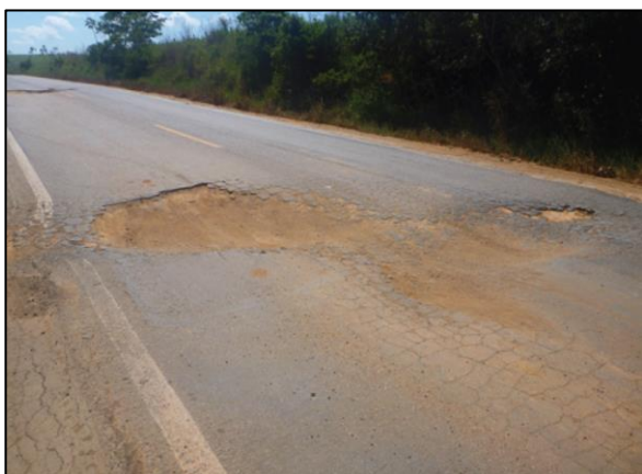
Figura 15. Panela ou buraco. Fonte: CNT (2017) 6 .
