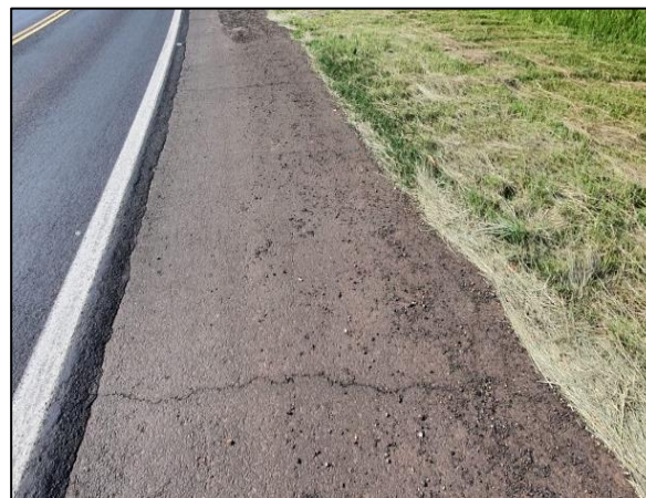
Figura 19. Trinca isolada transversal. Fonte: Autores (2022).
