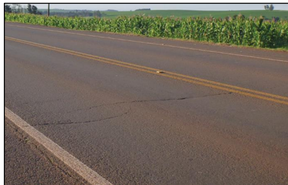
Figura 5. Trinca transversal. Fonte: CNT (2017) 6 .
