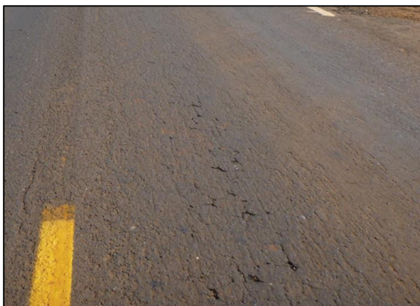
Figura 14. Desgaste. Fonte: CNT (2017) 6 .
