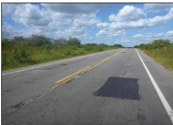
Figura 16. Remendo Fonte: CNT (2017) 6 .
