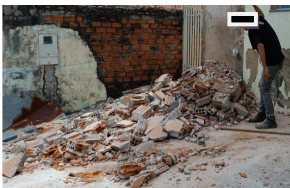
Figura 8. Pilar em alvenaria após demolição. Fonte: Elaborado pelo autor (2023)
