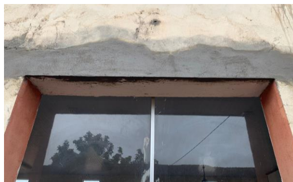
Figura 6. Visão da área afetada após demolição. Fonte: Elaborado pelo autor (2023).
