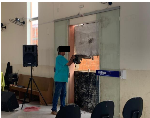
Figura 5. Demolição de marquise colapsada. Fonte: Elaborado pelo autor (2023)
