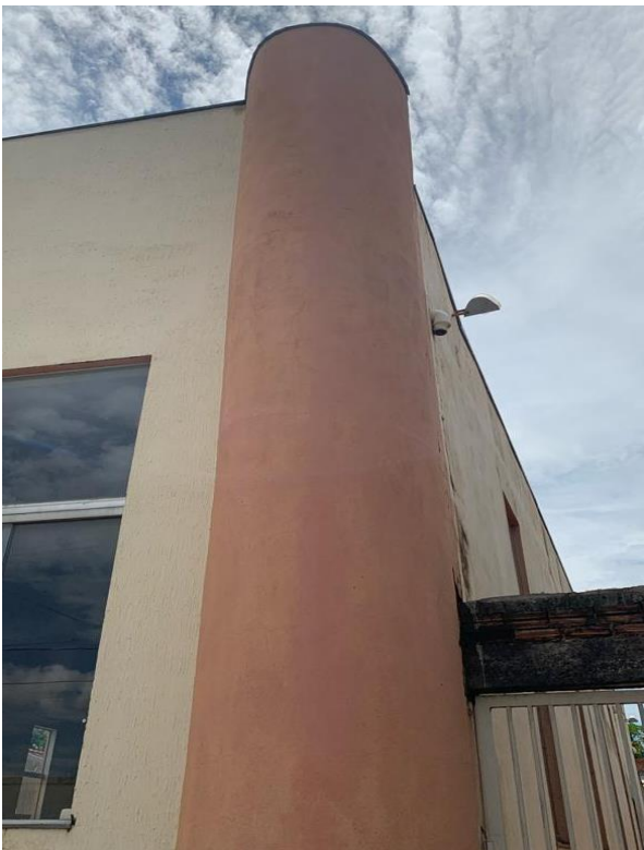
Figura 9. Pilar em alvenaria a ser demolido como prevenção. Fonte: Elaborado pelo autor (2023).
