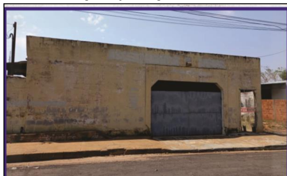
Figura 1. Fachada do primeiro Templo Inspeccionado. Fonte: Elaborado pelo autor (2023)
