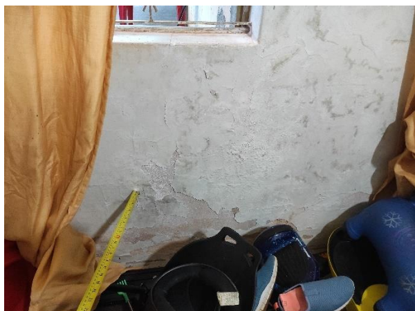
Figura 22. Vesícula de umidade. Fonte: Os autores (2023).
