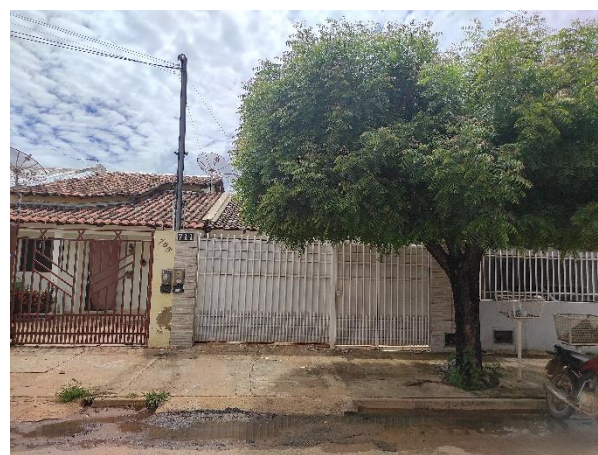
Figura 2. Vista da fachada frontal da residência 1. Fonte: os autores (2023).
