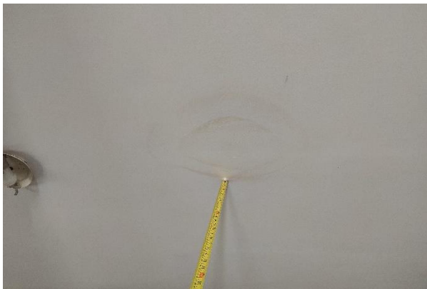
Figura 15. Mancha de umidade. Fonte: Os autores (2023).
