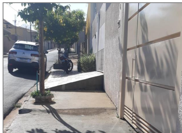
Figura 3. Trecho com inclinação transversal elevada devido a ajuste para acesso de veículos. Fonte: Elaborado pelos autores
