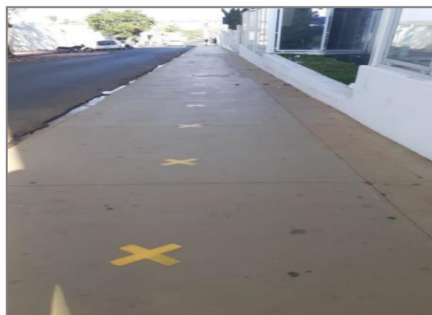
Figura 8. Trecho identificado como acessível: presença de piso regular, construído em concreto (material firme e antiderrapante), sem obstruções. Fonte: Elaborado pelos autores
