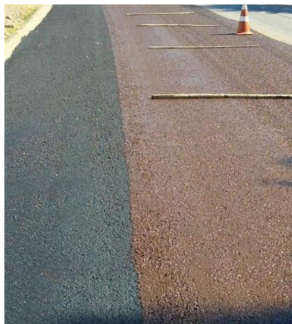
Figura 10 : Micro revestimento asfáltico á frio. Fonte: Terrena Asfaltos e Pavimentações (2019).
