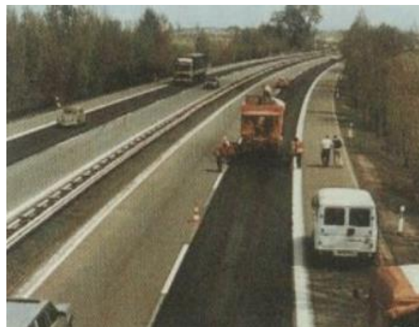
Figura 9: Alemanha, final da década de 60. Fonte: Greca Asfaltos (1965)
