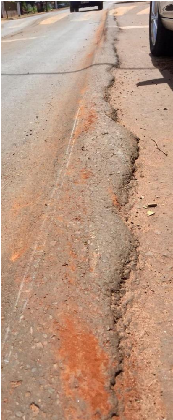
Figura 6: Ondulação ou corrugação na Av. Valério Osmar Estevão, Ângulo – PR. Fonte: Elaborado pelo Autor (2019).
