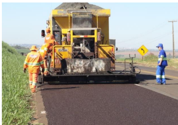
Figura 11: Aplicação de MRFA. Fonte: Novo Asfalto (2018)
