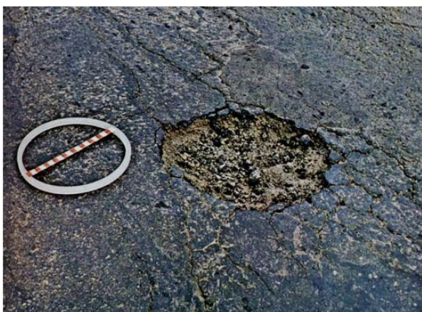
Figura 9. Panela. Fonte: DNIT 005/2003 – TER (2003) 7 .
