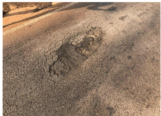
Figura 14. Panela. Fonte: os autores (2022).
