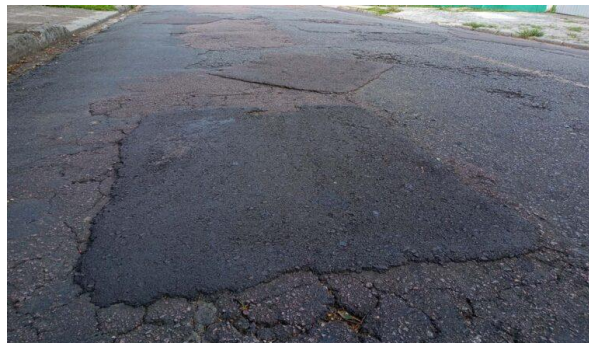
Figura 11. Remendo superficial. Fonte: DNIT 005/2003 – TER (2003) 7 .
