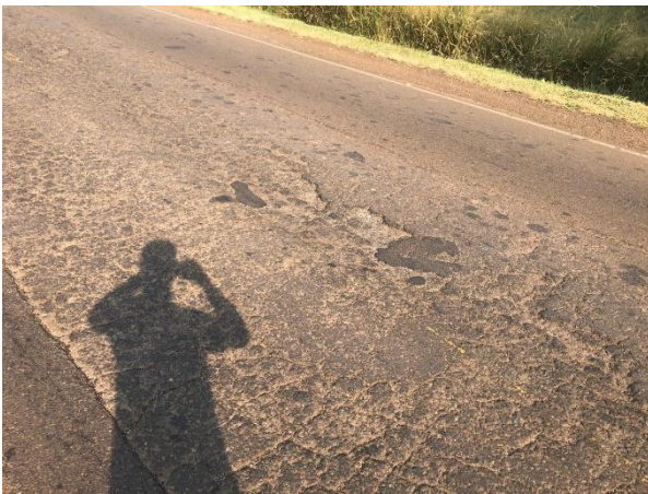
Figura 17. Desgaste. Fonte: os autores (2022).
