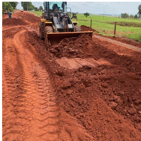
Figura 6: Maquinário no auxílio da troca de solo. Fonte: Autor (2021).
