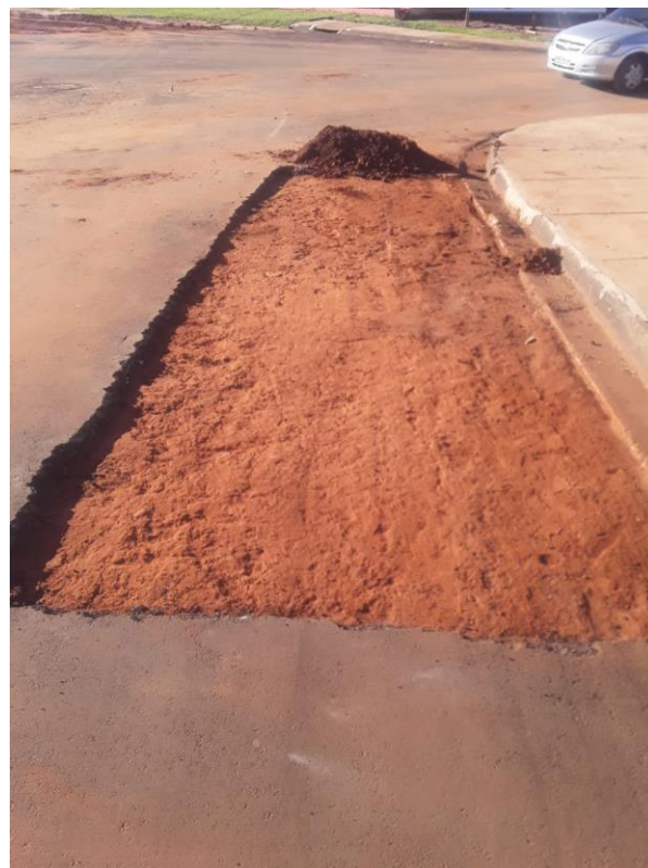
Figura 7: Retirada de pavimento com borrachudo. Fonte: Autor (2021).
