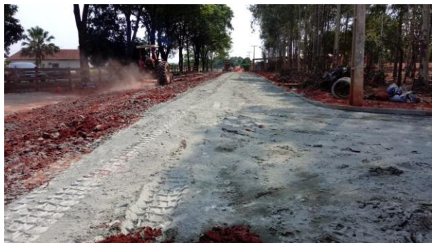
Figura 4: Aplicação de cimento no Solo. Fonte: Autor (2021).
