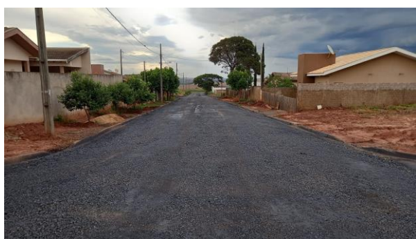
Figura 8. Solo cimento executado com ligante aplicado. Fonte: Autor (2022).
