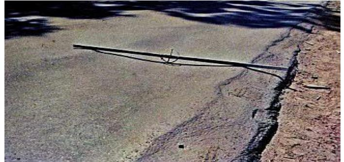
**Figura 09.** Afundamento de trilha de roda. **Fonte:** Departamento Nacional de Infraestrutura de Transporte, Norma DNIT 005/2003 – TER (2003)<sup>15</sup>.
