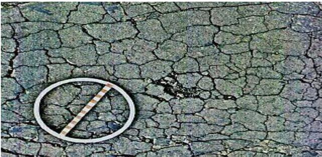
**Figura 7.** Trinca interligada – tipo couro de jacaré. **Fonte:** Departamento Nacional de Infraestrutura de Transporte, Norma DNIT 005/2003 – TER (2003)<sup>15</sup>.
