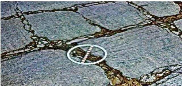
**Figura 8.** Trinca interligada – tipo bloco. **Fonte:** Departamento Nacional de Infraestrutura de Transporte, Norma DNIT 005/2003 – TER (2003)<sup>15</sup>.
