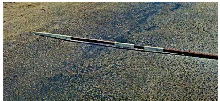
**Figura 10.** Afundamento local. **Fonte:** Departamento Nacional de Infraestrutura de Transporte, Norma DNIT 005/2003 – TER (2003)<sup>15</sup>.
