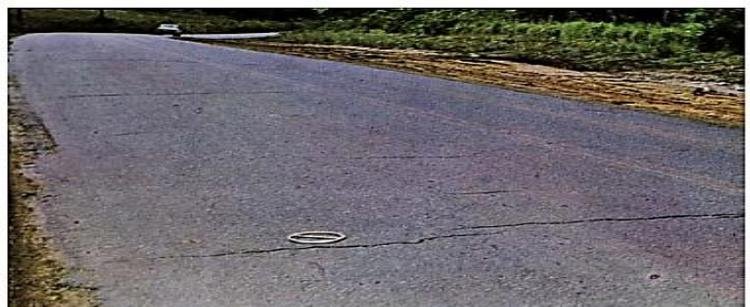
**Figura 5.** Trinca isolada – transversal. **Fonte:** Departamento Nacional de Infraestrutura de Transporte, Norma DNIT 005/2003 – TER (2003)<sup>15</sup>.
