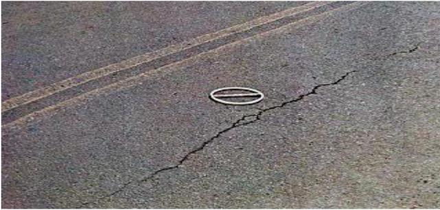
**Figura 6.** Trinca isolada – longitudinal. **Fonte** Departamento Nacional de Infraestrutura de Transporte, Norma DNIT 005/2003 – TER (2003)<sup>15</sup>.
