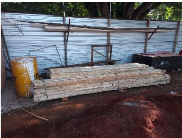
Figura 10. Armazenagem de madeiramento e tubos de PVC. Fonte: os Autores (2019).
