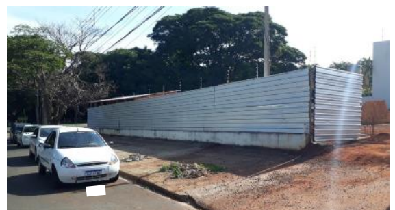
Figura 13. Ausência de entrada/saída para colaboradores. Fonte: os Autores (2019).
