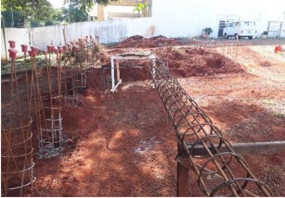
Figura 7. Local para armação de aço. Fonte: os Autores (2019).
