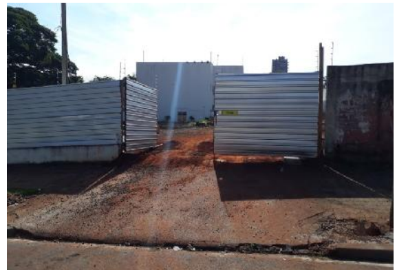
Figura 12. Tapume de isolamento da obra. Fonte: os Autores (2019).
