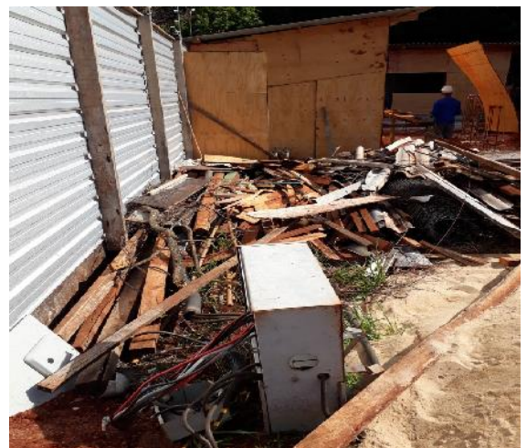
Figura 14. Entulho exposto dentro da obra. Fonte: os Autores (2019).
