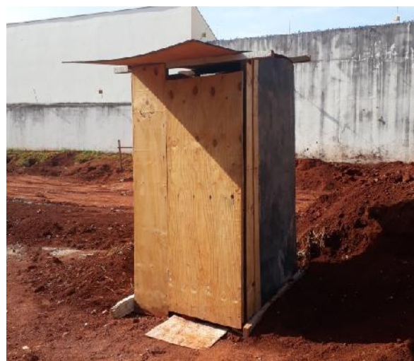
Figura 5. Construção temporária para vaso sanitário. Fonte: os Autores (2019).
