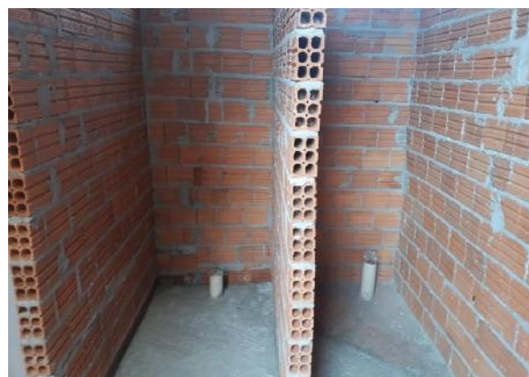
Figura 4. Gabinete Sanitário em construção. Fonte: os Autores (2019).
