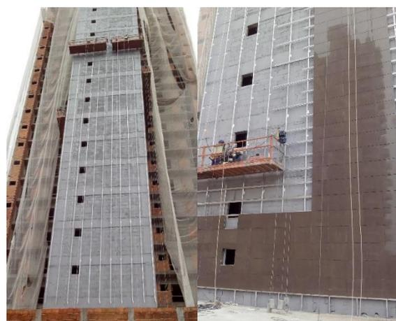
**Figura 6.** Sequência de colocação dos perfis verticais, horizontais e revestimento. **Fonte:** [10].
