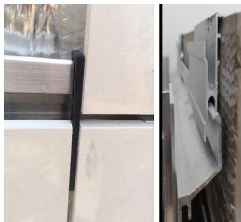
**Figura 5.** Encaixe do porcelanato ao perfil e espaçador. **Fonte:** [10].
