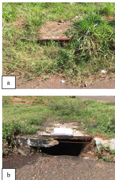
**Figura 1.a)** Obstrução na sarjeta da boca de lobo e **b)** Sarjeta com princípio de obstrução e meio-fio deteriorado na entrada da boca de lobo. Fonte: Elaborado pelo autor (2018)
