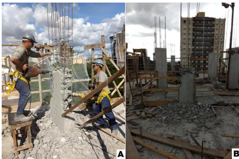
Figura 1. Demolição de pilares – (1 A) Operários demolindo pilares – (1B) Pilares a serem demolidos. Fonte: AUTORA, 2018.
