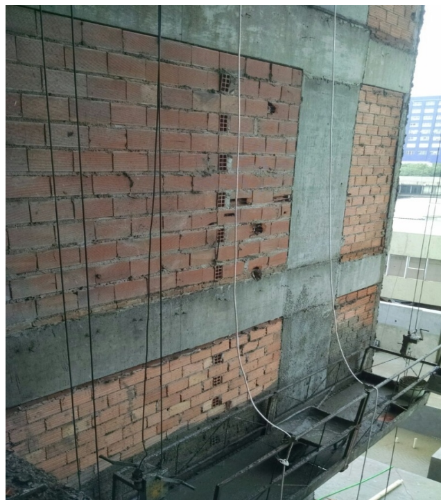
Figura 2. Depressões, furos e rasgos não corrigidos na alvenaria.
