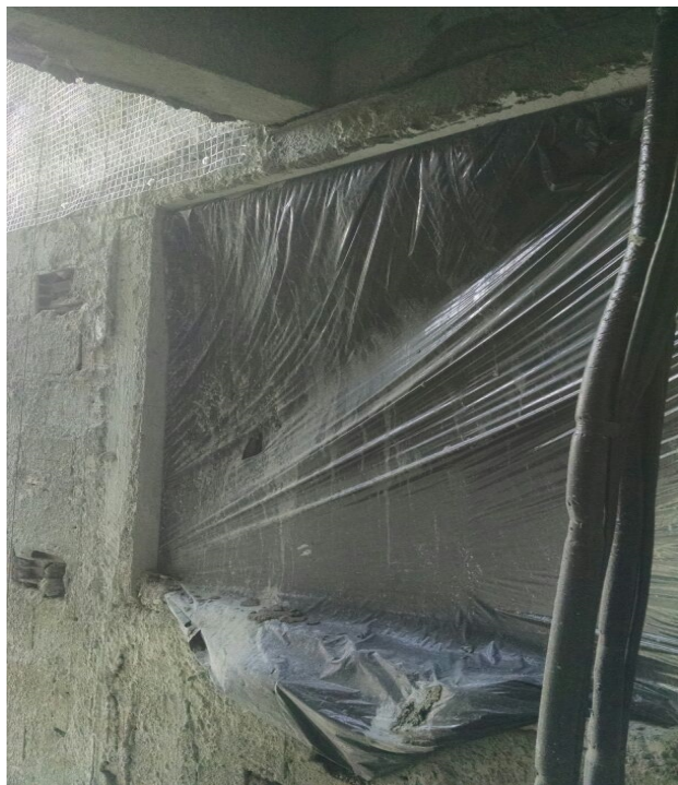
Figura 4. Reboco com espessura superior a 3 cm sem reforço com tela metálica entre cada camada.
