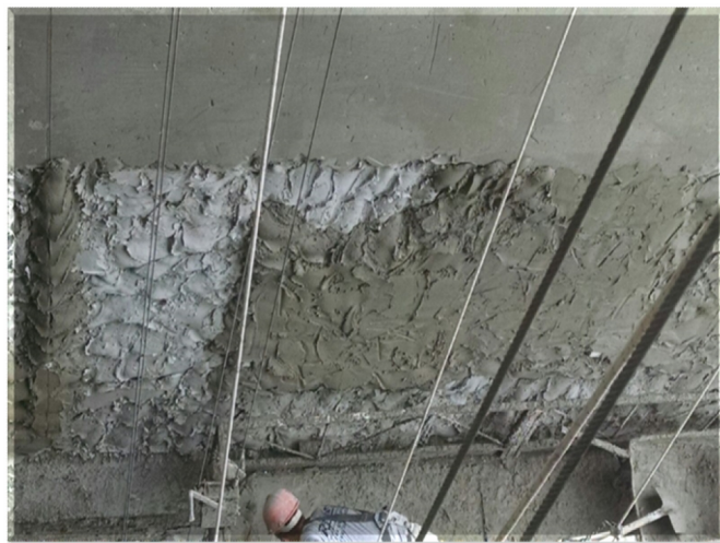
Figura 4. Reboco com espessura superior a 3 cm sem reforço com tela metálica entre cada camada.
